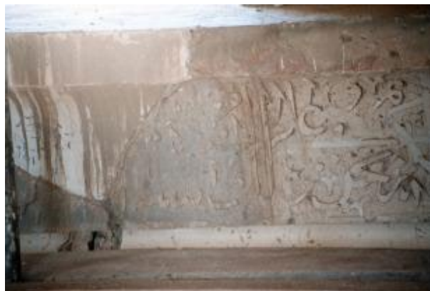
شکل ۲۲. آلودگی سطح کتیبه در اثر ریزش نزولات جوی از طریق سقف (عکس از نگارنده)
