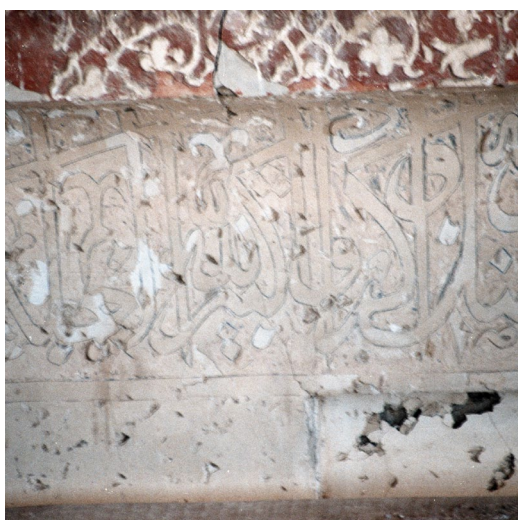
شکل ۲۷. ریزش رنگ آبی بستر کتیبه گچبری چپ و راست (عکس از نگارنده)
