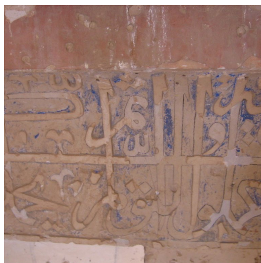
شکل ۲۷. ریزش رنگ آبی بستر کتیبه گچبری چپ و راست (عکس از نگارنده)
